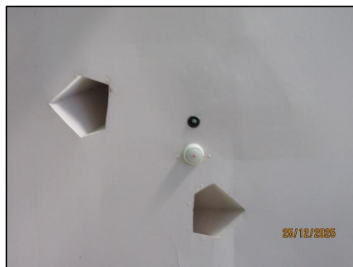
รูปที่ 59 เครื่องตรวจจับควัน (Smoke Detector)
