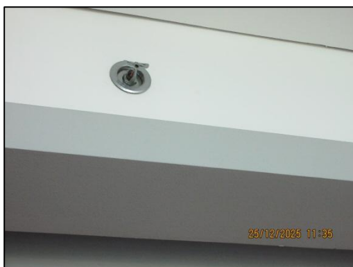
รูปที่ 52 หัวกระจายน้ำดับเพลิง (Sprinkler Head)
