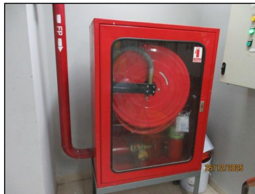
รูปที่ 53 ตู้สายน้ำดับเพลิง (Fire Hose Cabinet)
