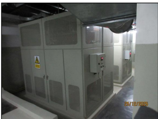
รูปที่ 42 ชุด Power Monitoring ที่ตู้ MDB
