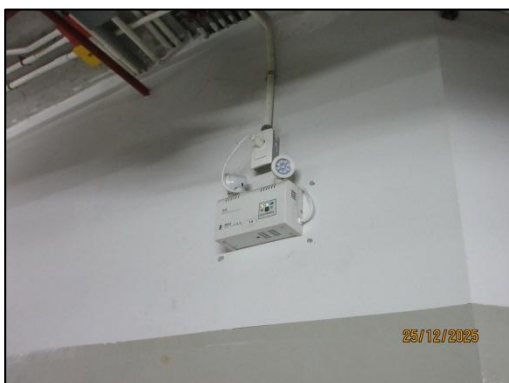
รูปที่ 62 ไฟฉุกเฉิน (Emergency Light)
