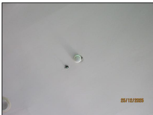
รูปที่ 59 เครื่องตรวจจับควัน (Smoke Detector)
