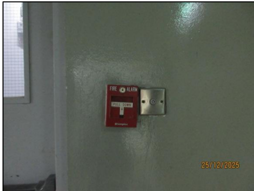
รูปที่ 57 ชุดกดแจ้งเหตุ (Manual Station)
