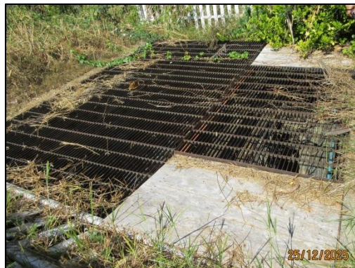
รูปที่ 18 บ่อหน่วงน้ำรองรับน้ำฝนของโครงการ
