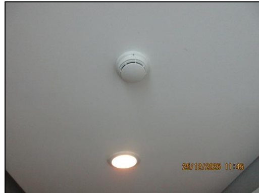
รูปที่ 59 (ต่อ) เครื่องตรวจจับควัน (Smoke Detector)
