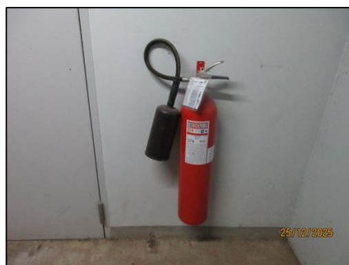
รูปที่ 54 ถังดับเพลิงแบบมือถือ (Portable Fire Extinguisher)
