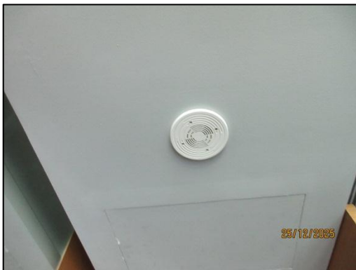
รูปที่ 58 อุปกรณ์ส่งเสียงแจ้งเหตุเพลิงไหม้
