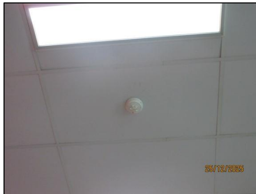
รูปที่ 60 เครื่องตรวจจับความร้อน (Heat Detector)
