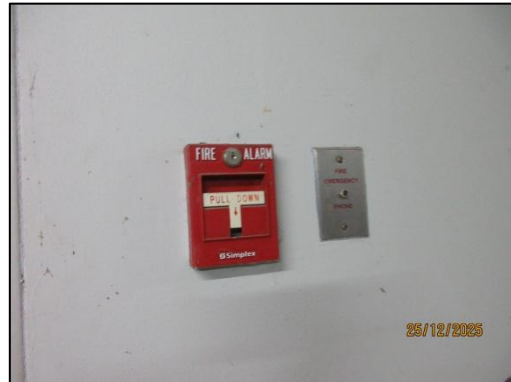
รูปที่ 57 ชุดกดแจ้งเหตุ (Manual Station)
