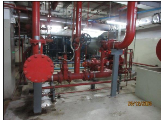
รูปที่ 49 ชุดเครื่องสูบน้ำดับเพลิง
