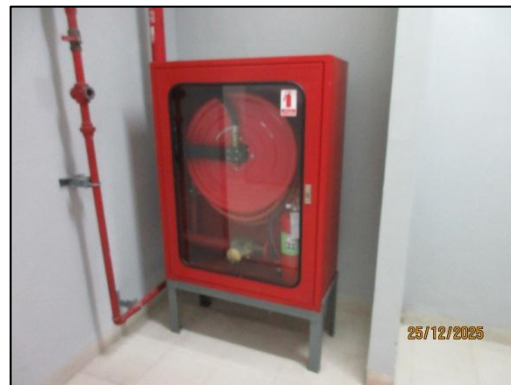
รูปที่ 53 ตู้สายน้ำดับเพลิง (Fire Hose Cabinet)
