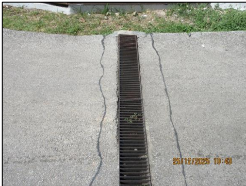
รูปที่ 17 รางระบายน้ำฝนรอบโครงการ
