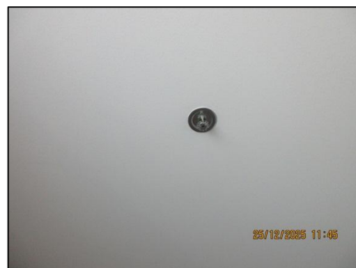
รูปที่ 52 หัวกระจายน้ำดับเพลิง (Sprinkler Head)
