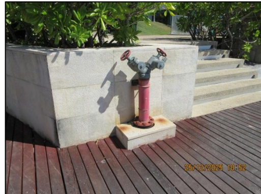
รูปที่ 51 (ต่อ) หัวจ่ายน้ำดับเพลิง
