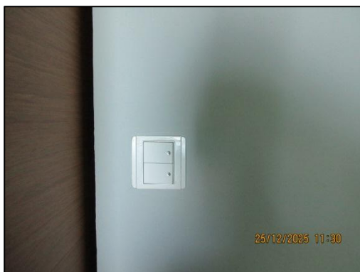
รูปที่ 46 สวิตช์ไฟแยกโดยไม่ขึ้นแก่กัน
