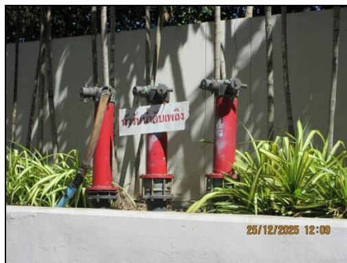
รูปที่ 50 หัวรับน้ำดับเพลิง (Fire Department Connection : FDC)
