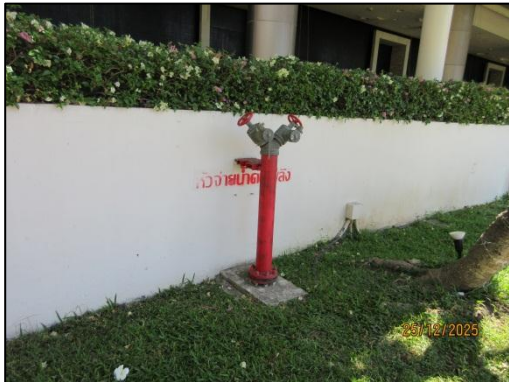
รูปที่ 51 (ต่อ) หัวจ่ายน้ำดับเพลิง
