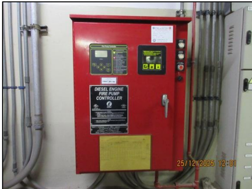
รูปที่ 49 ชุดเครื่องสูบน้ำดับเพลิง
