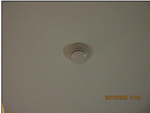
รูปที่ 59 (ต่อ) เครื่องตรวจจับควัน (Smoke Detector)
