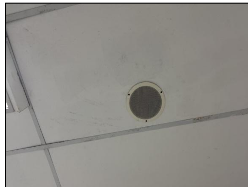
รูปที่ 58 อุปกรณ์ส่งเสียงแจ้งเหตุเพลิงไหม้
