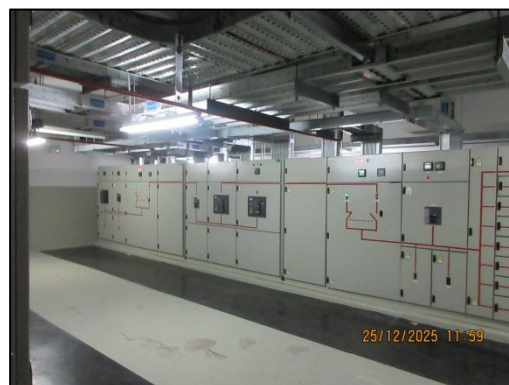
รูปที่ 42 ชุด Power Monitoring ที่ตู้ MDB
