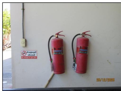
รูปที่ 54 ถังดับเพลิงแบบมือถือ (Portable Fire Extinguisher)
